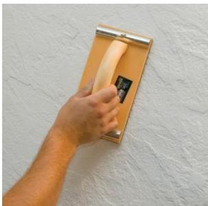
После полного высыхания первого слоя, поверхность шлифуется для удаления гребешков, «задиrow» и неровностей с помощью шлифовальной терки (размер зерна 12-16). Возможную пыль удалить щеткой.
