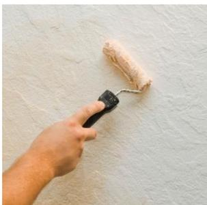
Нанесение финишного покрытия. Колерованная Лазурь наносится на готовую поверхность меховым валиком. Во избежание образования стыков необходимо наносить финишное покрытие на всю обрабатываемую поверхность сразу, от угла до угла.
