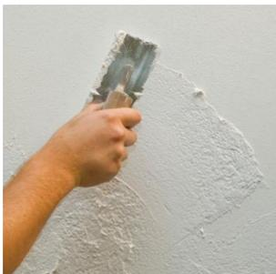
Первый слой покрытия наносится кельмой равномерным слоем от 1 до 3 мм.
