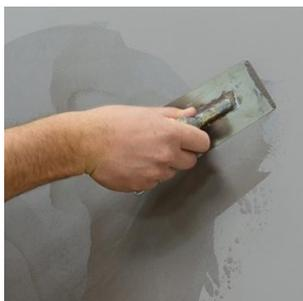
Первый слой заколерованного материала наносится кельмой ровным тонким слоем.
