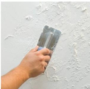
Затем, не дожидаясь подсыхания материала, наносится рельефный рисунок.
