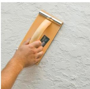
После полного высыхания поверхность шлифуется для удаления «ребешков», «задигов» и неровностей с помощью шлифовальной терки (размер зерна 12-16). Возможную пыль удалить щеткой.
