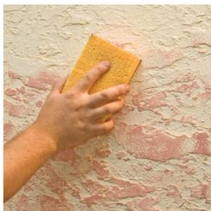
Для придания покрытию большей выразительности с помощью губки наносится колерованная краска, не прокрашивая углубления в фактуре покрытия. Для этого необходимо вылить небольшое количество краски на любую ровную поверхность и обмакнуть в нее губку, сняв излишки о сухую поверхность. Данный процесс необходимо повторять перед каждым нанесением краски.
