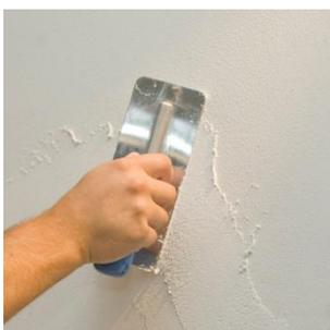
Первый слой наносится кельмой равномерным слоем на толщину наполнителя.
